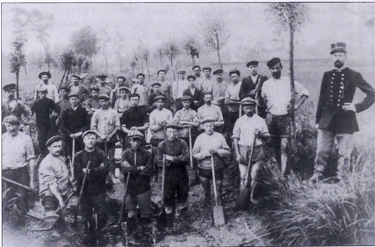
Arbeiders voeren beheerswerken uit in de Zeverenbeek anno 1911. (Foto Denis Pieters)
